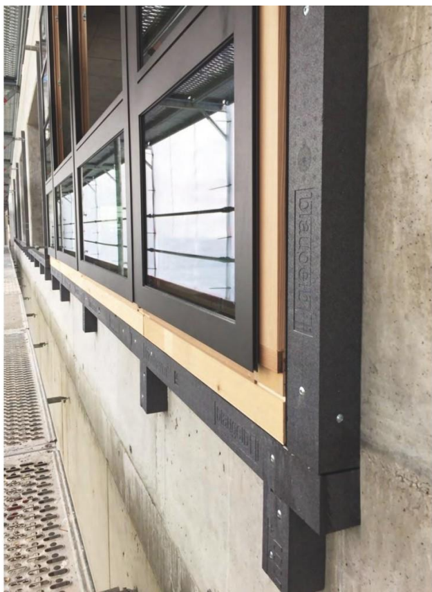
Foto 4 – montaj tâmplărie cu precadre (înainte de aplicarea termosistemului)
