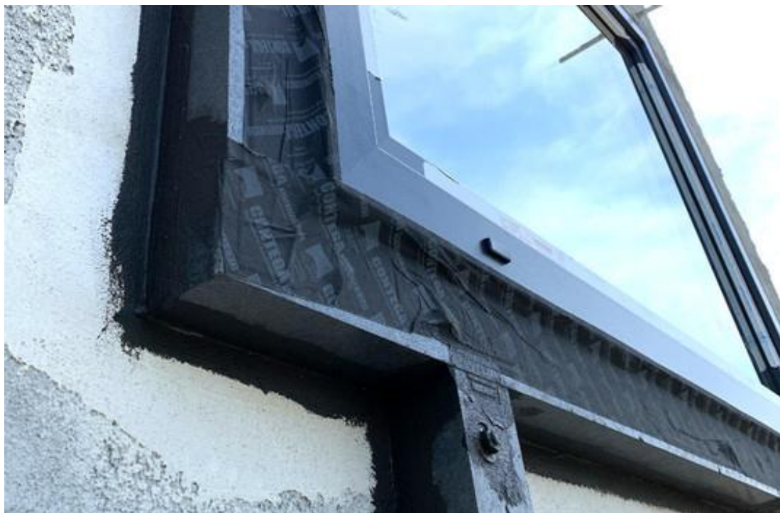
Foto 5 – detaliu montaj tâmplărie – folii / benzi de etanșare și membrană de etanșare lichidă
