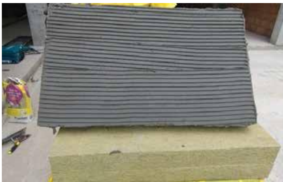
Foto 2 – exemplu de aplicare adeziv cu gletiera cu dinți de 10 mm
