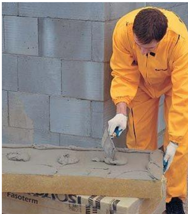
Foto 3 – exemplu de aplicare adeziv în puncte și pe contur
